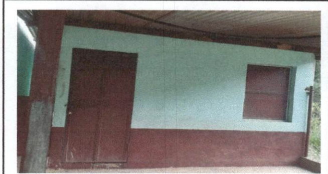
Foto7: ampliación de cocina
